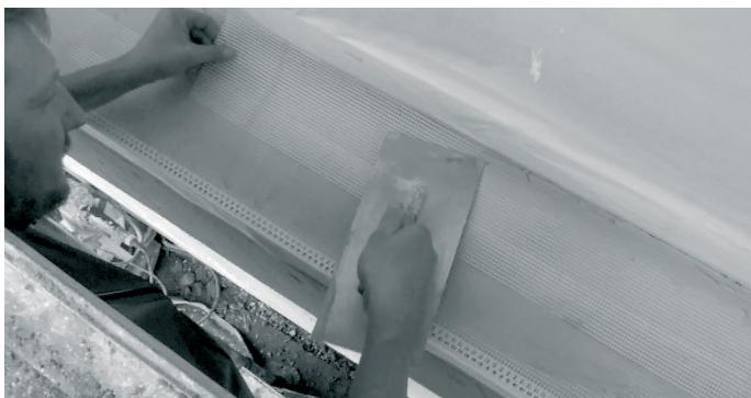
9. Na vnější hranu parapetu vlepte do lepícího a stérkového tmelu rohový (parapetní) profil se síťovinou a na plochu vložte armovací síťovinu.
