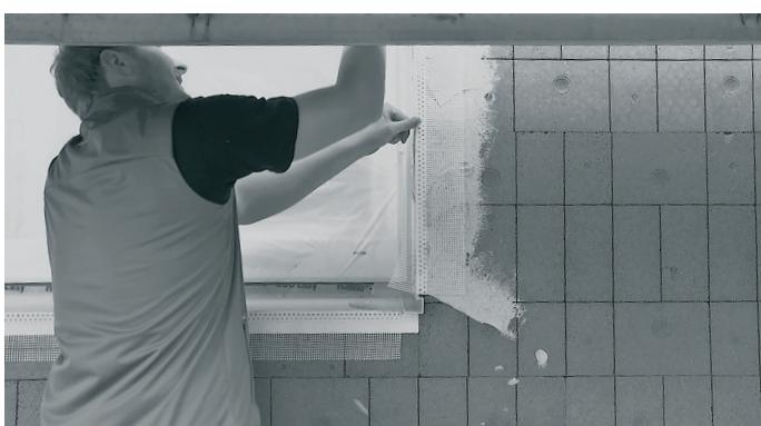
11. Vytvořte napojení základní vrstvy použitím rohových profilů a diagonální armovací síťoviny.
