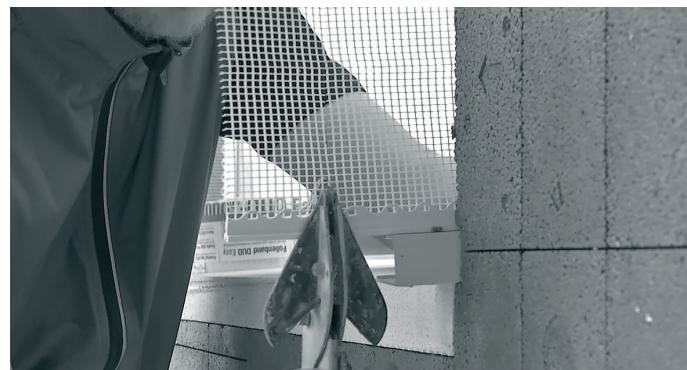
4. Na příslušnou délku zkráťte nasunovací lištu se síťovinou. Lišta se nasunuje na profil SOL-PAD hladkou stranou plastu k ostění.
