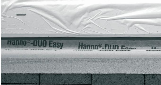
5. Spáru v napojení izolačního spádového klínu na parapetní podkladní profil přelepte samolepící těsnící páskou.
