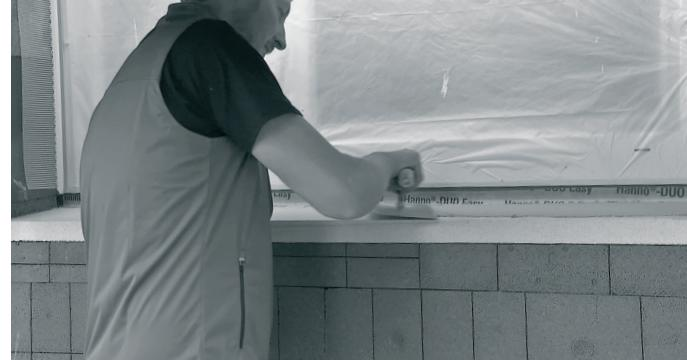
6. Na plochu izolačního spádového klínu naneste celoplošně lepicí a stěrkový tmel.
