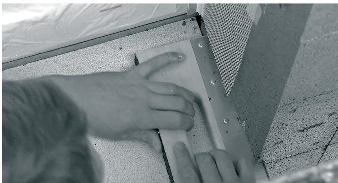
3. Podél izolačního klínu nástrojem SOL-PAD TOOL vyřízněte a vybrusťte po obou stranách ostění kapsy pro profily SOL-PAD v tepelné izolaci.
