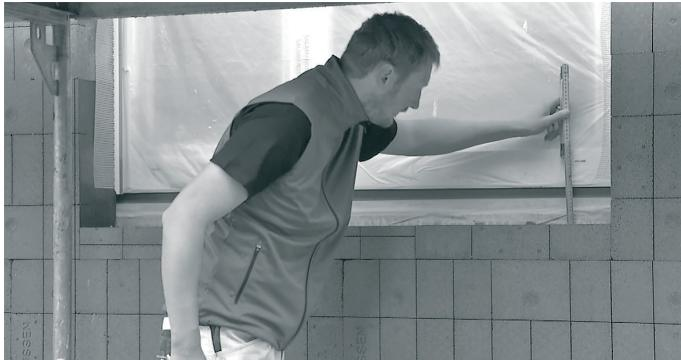
1. Vytvořte potřebnou mezitu 10 cm mezi fasádním izolantem a rámem okna. V případě potřeby izolant přebrusťte (pro SOL-PAD 280/30 vytvořte potřebnou mezitu 11 cm).
