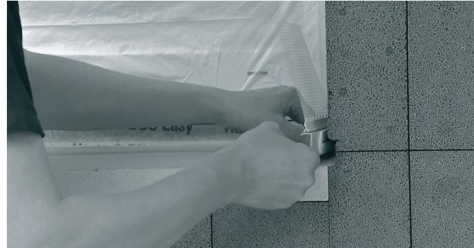
8. Profily SOL-PAD vlepte do připravených kapes v ostění. Zadní část SOL-PADu se musí zasunout na doraz na podkladní profil okna.
