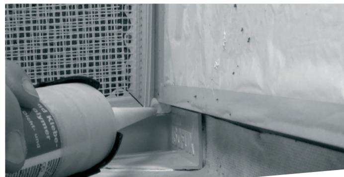
10. Dutinu ve vnitřním rohu profilu SOL-PAD uzavřete polymerním lepidlem.
