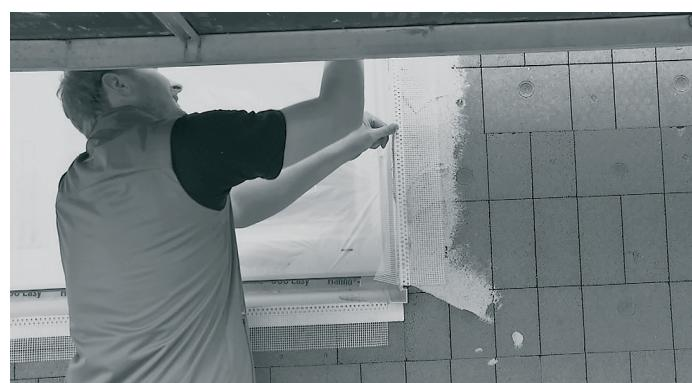
12. Po dokončení základní vrstvy odřízněte přesahující profil SOL-PAD nástrojem SOL-PAD TOOL a zaměřte rozměry parapetního plechu.
