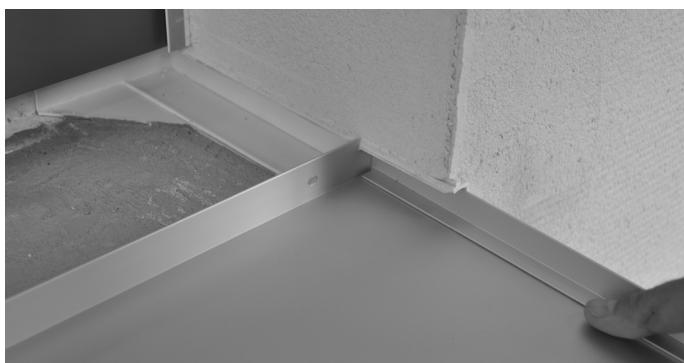
15. Dokončete finální omítku. Na zadní lem plechu nalepte komprimační pásku. Parapetní plech zasuňte a připelete a nebo přišroubujte na podkladní profil. (V případě lepení parapetního plechu naneste před jeho zasunutím na parapetní plochu polymerní lepidlo.)
