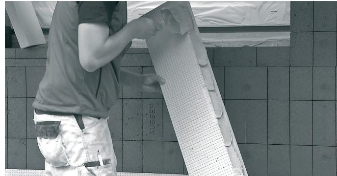
2. Zařízněte přední čelo izolačního spádového klínu se **spádem 5°** na požadovanou hloubku. Naneste na zadní stranu izolačního spádového klínu lepicí a stěrkový tmel a vlepte klín do parapetního lože.
