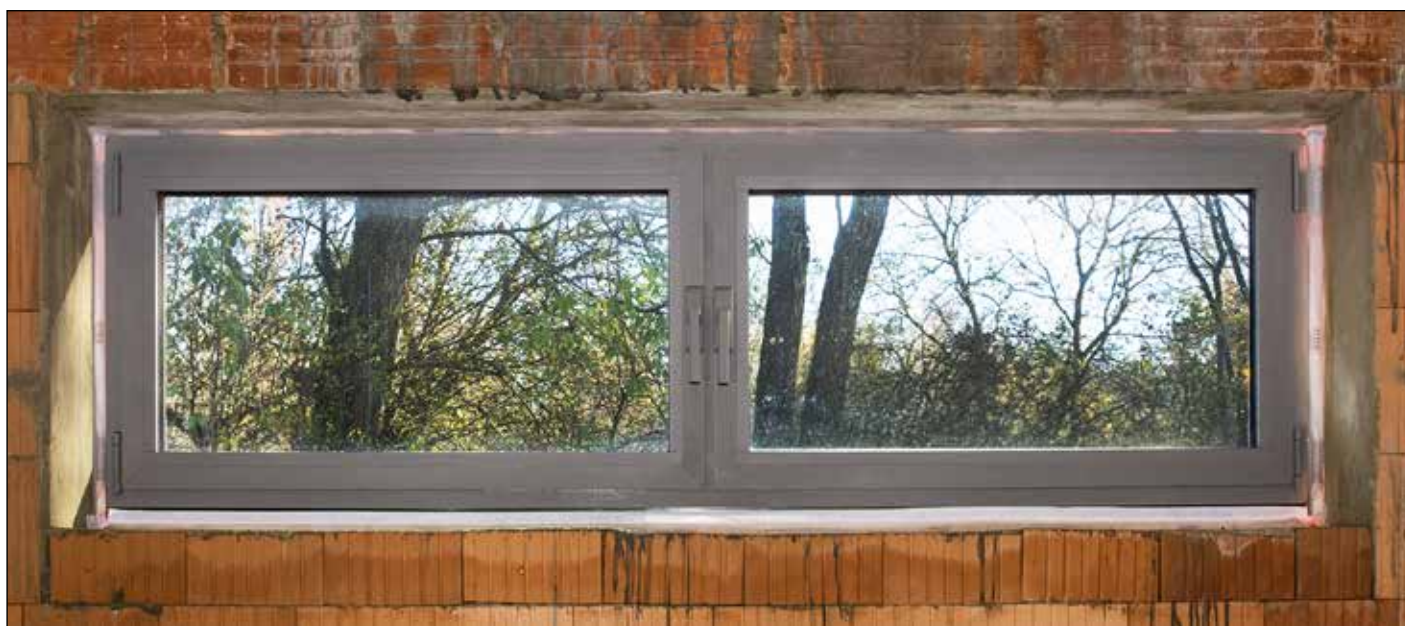
Příklad zabudovaného okna systémem předsažené montáže WIN-ROCK - pohled z interiéru
