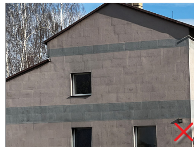
Poškozený ETICS vlivem polštářového efektu a nevhodného kotevního schématu
